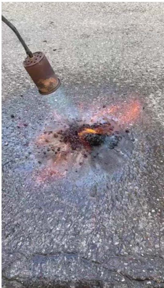
Fot. 2. Przykład użycia palnika do podgrzewania masy asfaltowej na zimno podczas wypełniania otworu pozostałego po odwierceniu próbki z nawierzchni
