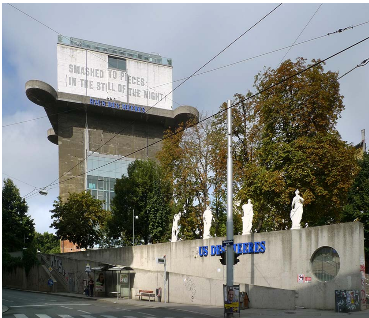
Ryc. 12. Widok na mur oporowy ograniczający trójkątną działkę Parku Esterházy strony skrzyżowania Gumpendorferstraße i Windmühlgasse – dominanta dzisiejszego Haus des Meeres w bryle dawnej Flakturm, fot. A. Staniewska 2015
