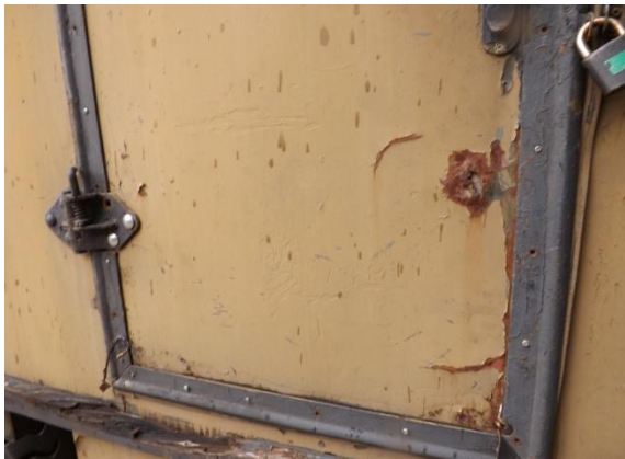
Rys. 4. Uszkodzenia metalicznej powłoki
