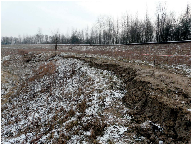
Rys. 3. Osuwisko w narożniku południowo-zachodnim wyrobiska Piaseczno stan ze stycznia 2016 r.
