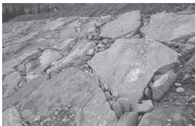
Rys. 8. Ukończony odcinek narzutu nr 3
