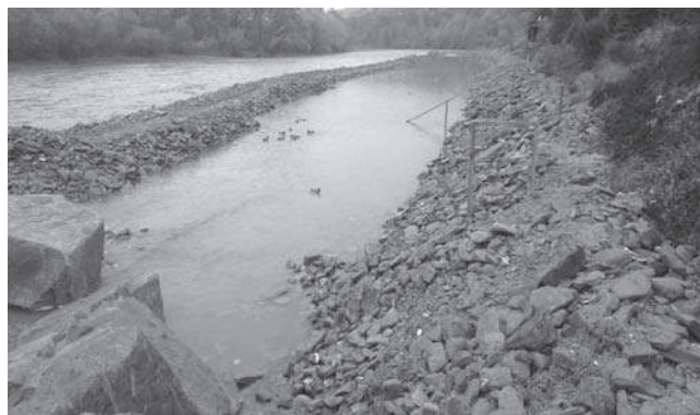
Rys. 7. Narzut nr 3 w konstrukcji
