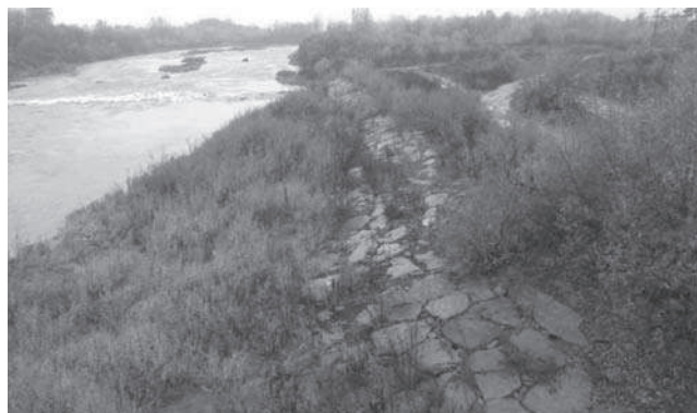
Rys. 3. Widok na narzut nr 1 z mostu kolejowego (w stronę ujścia)
