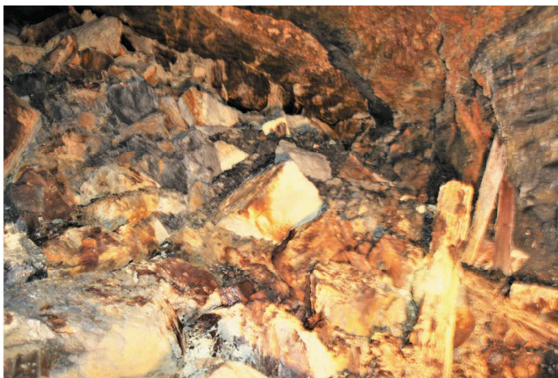
Rys. 6. Komora za tamą TI-7N - po przejściu przez obwał. Komora o szerokości 10 – 15 m z obwałem skał stropowych i ociosowych (głazy 5,0 x 6,0 m). Nachylenie płaszczyzny obwału w stosunku do ociosów komory – 45°, długość po obwałie 50 m (archiwum MGW)
