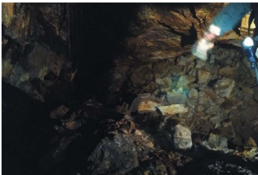
Rys. 4. Zdjęcie zza tamy TI-1N - obwał przed wejściem do komory (archiwum MGW)
