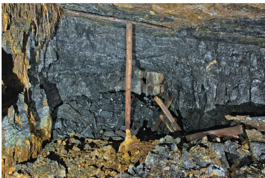
Rys. 5. Komora za tamą TI-1N - po przejściu przez obwał (archiwum MGW)
