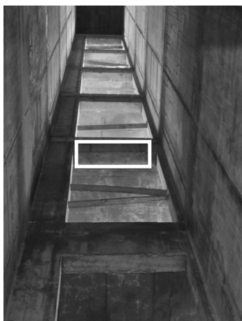
Rys. 1 Obiekt nr 1 – fragment monolitycznej konstrukcji wykonanej z betonu zbrojonego
