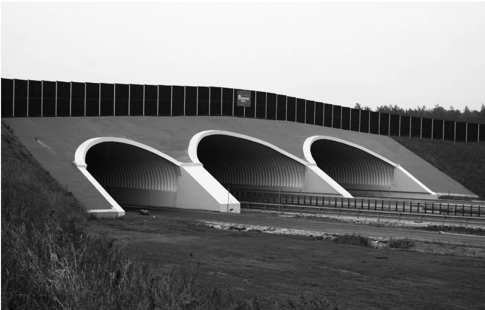
Fot. 9. Przejście górne dla dużych zwierząt nad drogą ekspresową S-5 (odcinek: Poznań-Gniezno) i DW434 – jeden z najlepszych obiektów powstałych w 2012 r. (Fot. R. Kurek).
