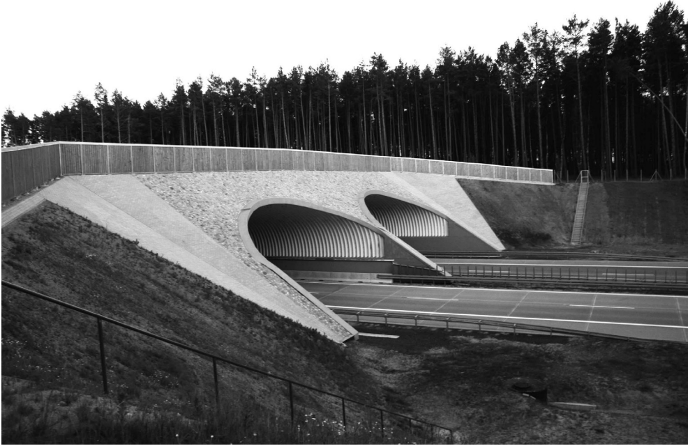
Fot. 8. Jedno z najlepszych przejść górnych dla dużych zwierząt w Polsce – „zielony most” o szerokości 50 m nad autostradą A2 (odcinek: Świecko-Trzciel) (Fot. R. Kurek).
