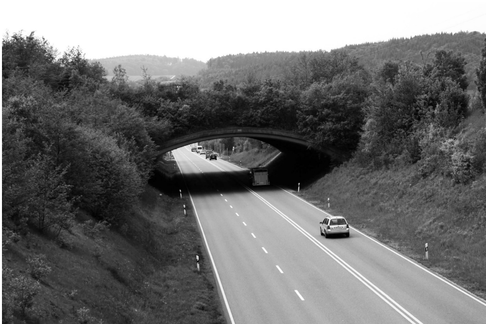
Fot. 3. Most krajobrazowy Hirschweg (droga B31n, Niemcy) – wybudowany w 1992 r., do dziś stanowi wzorcowe rozwiązanie w zakresie wkomponowania w otaczający krajobraz i siedliska przyrodnicze (Fot. R. Kurek).
