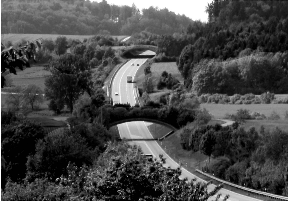
Fot. 2. Przejścia nad drogą B31neu w Niemczech wybudowane latach 1992-93 (łącznie 5 obiektów) określiły europejskie standardy projektowania przejść (Fot. R. Kurek).
