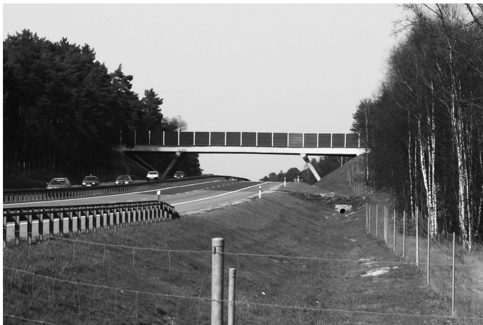
Fot. 4. Przykład wąskiego przejścia górnego (ok. 15 m szerokości) nad drogą S-5 k. Bydgoszczy, które zamyka epokę budowy tego typu obiektów w Polsce (Fot. R. Kurek).
