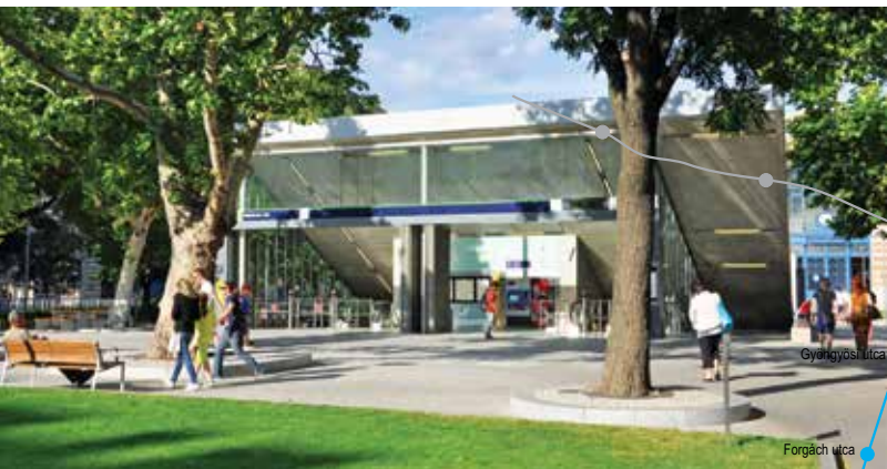
Wejście do stacji Rákóczi tér (20.06.2014 r.).
