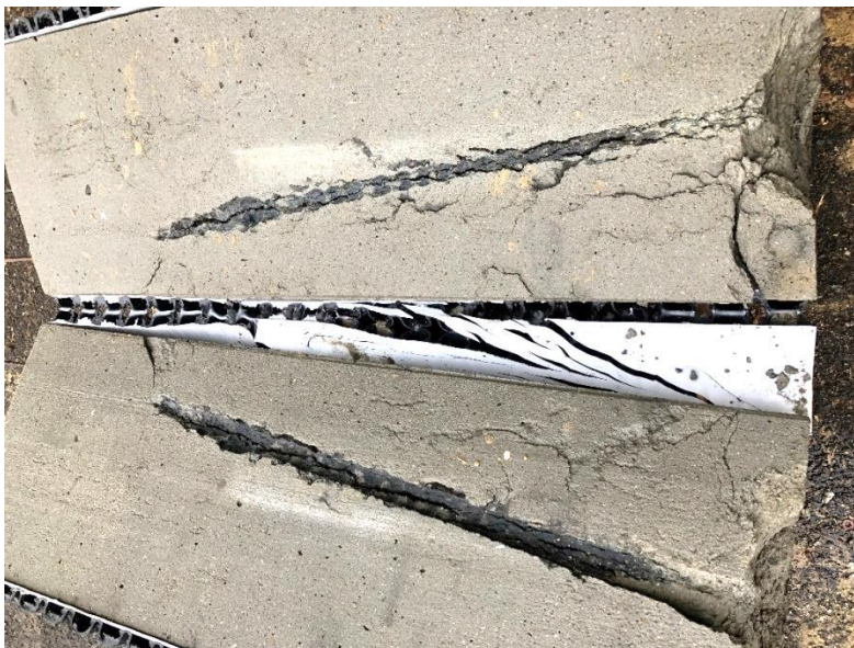
Rys. 8. Blok cementowy po rozcięciu (fot. GIG)
