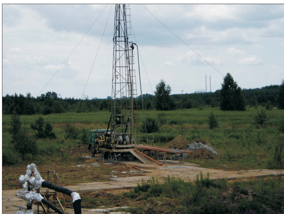
Ryc. 7. Wiercenie otworu eksploatacyjnego. Po lewej czynny otwór eksploatacyjny. W tle Elektrownia Połaniec. Fot. z Arch. Kopalni Siarki Osiek
