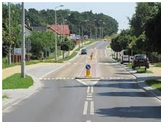
Foto.3. Wywyższone skrzyżowanie wraz z wyspą centralną pomiędzy pasami ruchu
