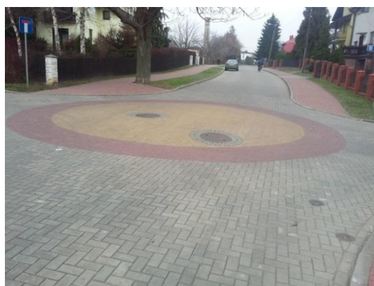
Foto.4. Próg zwalniający typu „pinezka” na skrzyżowaniu ulic Dębowej i Lipowej
