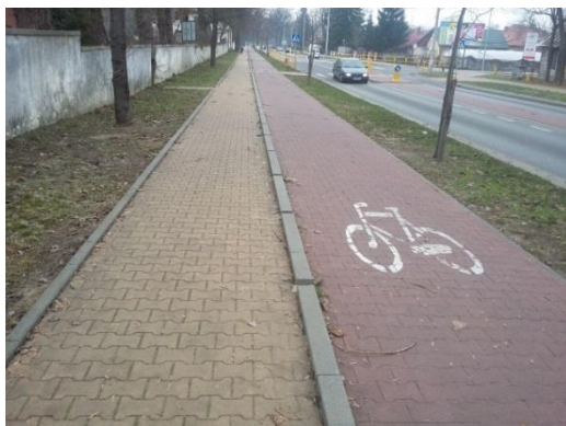
Foto.6. Betonowa palisada oddzielająca chodnik od drogi dla rowerów na ulicy Kazmierskiej
