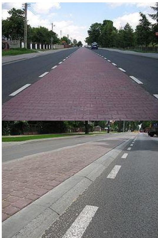
Foto. 2. Środkowy pas brukowany: u góry- szeroki (2,5m.), u dołu- wąski (1m.)
