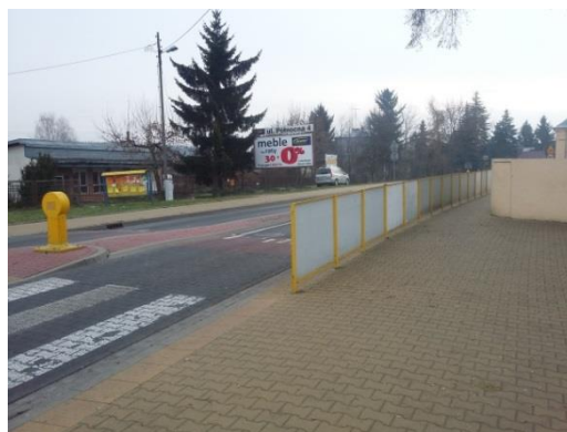
Foto.7. Bariery zapobiegające ochlapywaniu przechodniów na ulicy Włostowickiej
