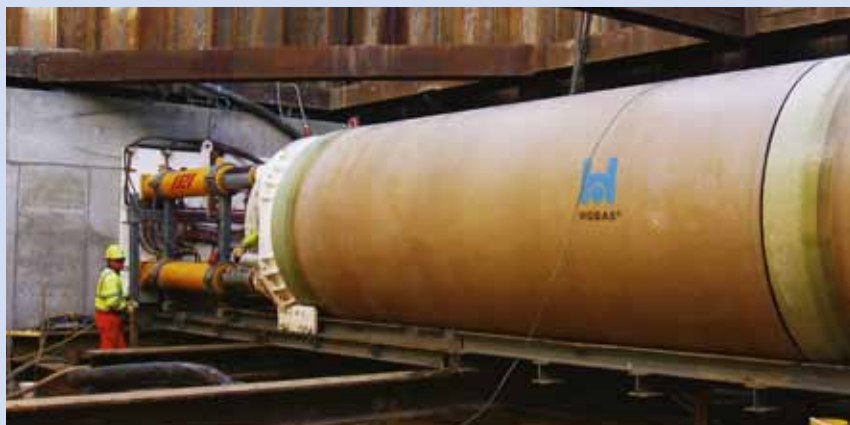
Przecisk hydrauliczny z użyciem rur Hobas
