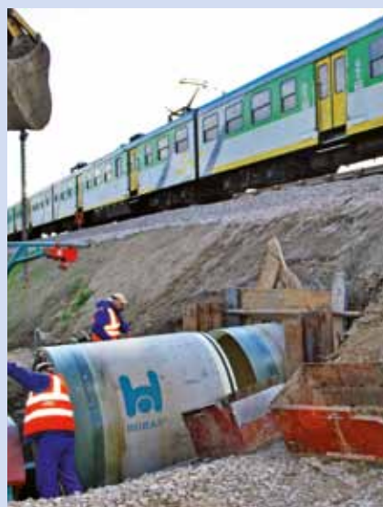
Instalacja rur Hobas pod liniami kolejowymi w okolicach Ciechanowa
