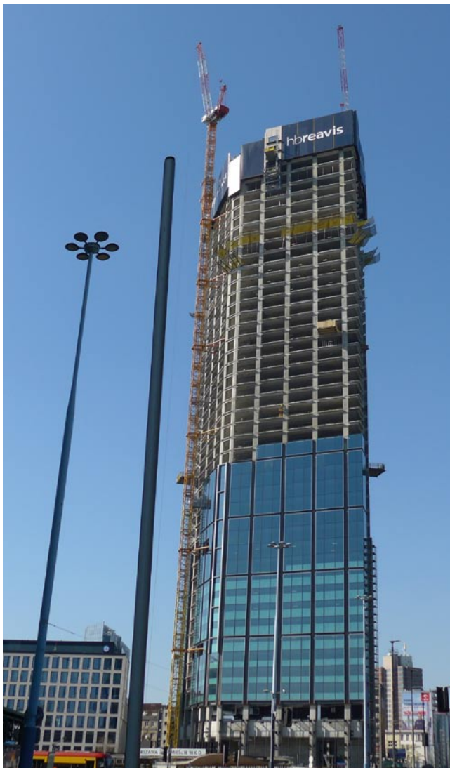
Rys. 4. Varso Tower w Warszawie
