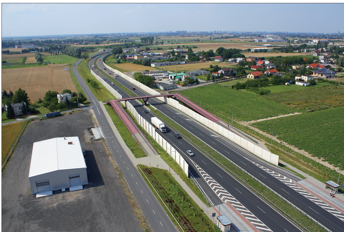
Droga ekspresowa S11 Poznań – Kórnik. Fot. Artur Gajdziński. Archiwum Transprojektu – Warszawa
