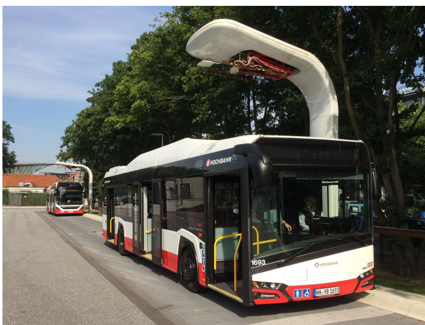
Rys. 6. Stanowisko do ładowania autobusów elektrycznych w Hamburgu (fot. www.hochbahn.de )
