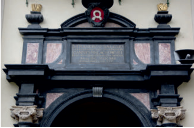
Fot. 1. Portal kościoła Wizyttek, Kraków ul. Krowoderska Fot. 1. Portal of the "Wizytki" Church, Krakow, Krowoderska Street
