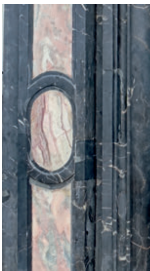
Fot. 8. Fragment portalu kościoła św. Wojciecha; zauważalna różnica między różanką a różowym marmurem zastępującym brakujące elementy Fot. 8. Fragment of the portal of St. Adalbert church. visible difference between red calcite named Rózanka and pink marble replacing missing items
