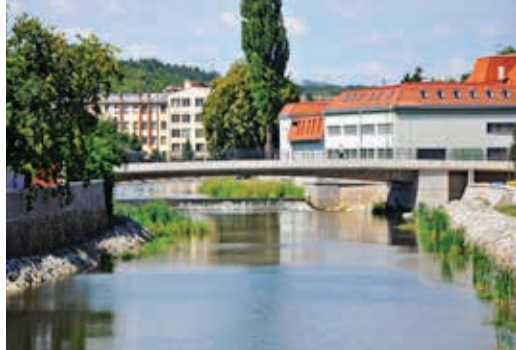
Betonowy most belkowy w Třebíči (obiekt nr 26)
