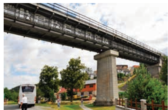
Stalowy most kolejowy na trasie Brno – Třebíč (obiekt nr 24)
