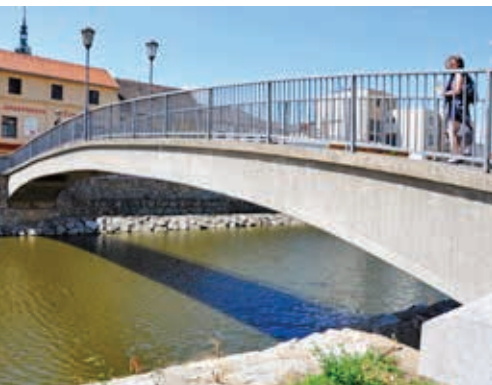
Betonowa, łukowa kładka dla pieszych w Třebíči (obiekt nr 25)
