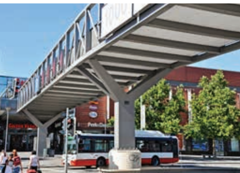
Stalowa kładka dla pieszych w Brnie (obiekt nr 23)
