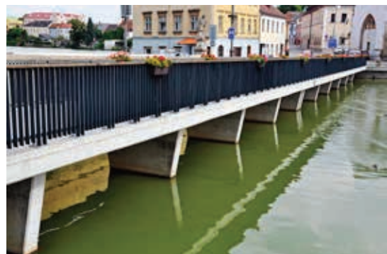
Żelbetowa, płytowa kładka dla pieszych w Jindřichův Hradec (obiekt nr 27)
