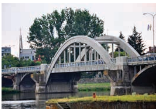
Żelbetowy most łukowy przez Wag w Pieszczyce (obiekt nr 22)
