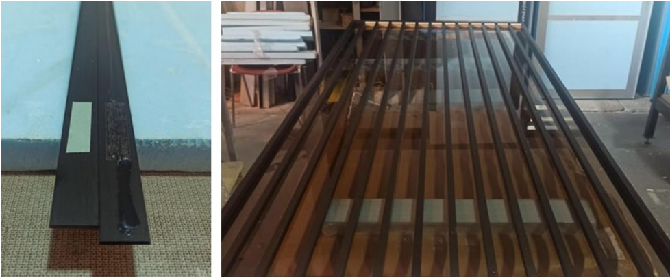
Fig. 5. Photos depicting attempts to bond glazing bars onto the glass leaf. Source: Photos from the collection of PIU Design Ryc. 5. Zdjęcia przedstawiające próby wklejania listew szprosowych na skrzydle szklanym. Źródło: Zdjęcia ze zbiorów firmy PIU Design
