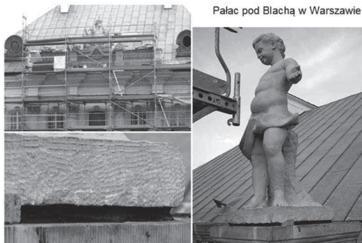
Rys. 8. Mocowanie figur na fasadzie Pałacu pod Blachą Zamku Królewskiego w Warszawie [5] Fig. 8. Fastening of statues on the facade of Palace "pod Blacha" in Zamek Krolewski in Warsaw [5]
