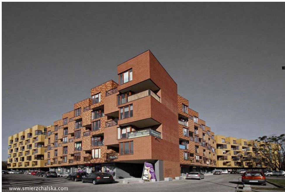
Rys. 5. Budynek mieszkalny Corte Verona we Wrocławiu, proj. Biuro Projektów Lewicki Łatak, 2010 [17].
