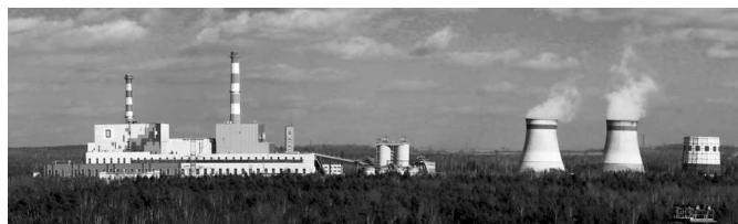
Rys. 3. Elektrownia Jaworzno II, po modernizacjach, 2014 r. [6]
