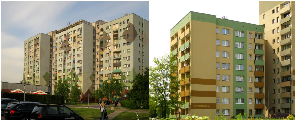
Fot. 5. Budynek mieszkalny przy ul.Broniewskiego 4-6. Projekt: arch. Bożena Włodarczyk.
