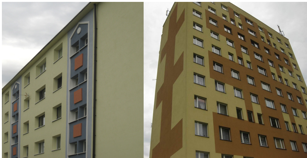
Fot. 3. Budynek mieszkalny przy ul. Edukacji 74-92. Projekt: Jerzy Lasik? Termomodernizacja w XXI wieku. Fot. 4. Wieżowiec 2-klatkowy przy ul. Starokościelnej 18. Budynek powtarzalny w technologii dostaczonej z NRD, adaptacja arch. Stanisław Niemczyk. Termomodernizacja w XXI wieku.
