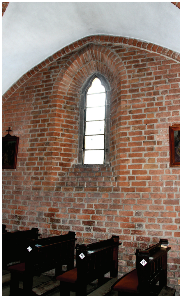
Il. 7. Wtórne okno w nawie południowej, widoczne przemurowania powstałe przy zwężeniu, stan obecny (fot. M. Dąbkowska)
