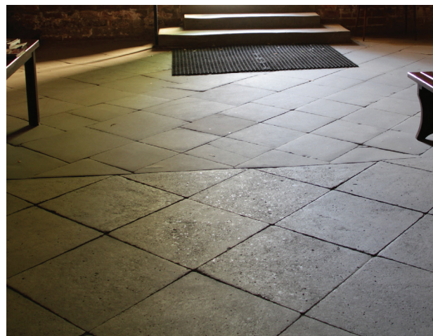
Il. 6. Posadzka w nawie głównej i południowej, widoczna różnica pomiędzy oryginalną (przy drzwiach), a wtórną posadzką (w nawie głównej), stan obecny (fot. M. Dąbkowska)
