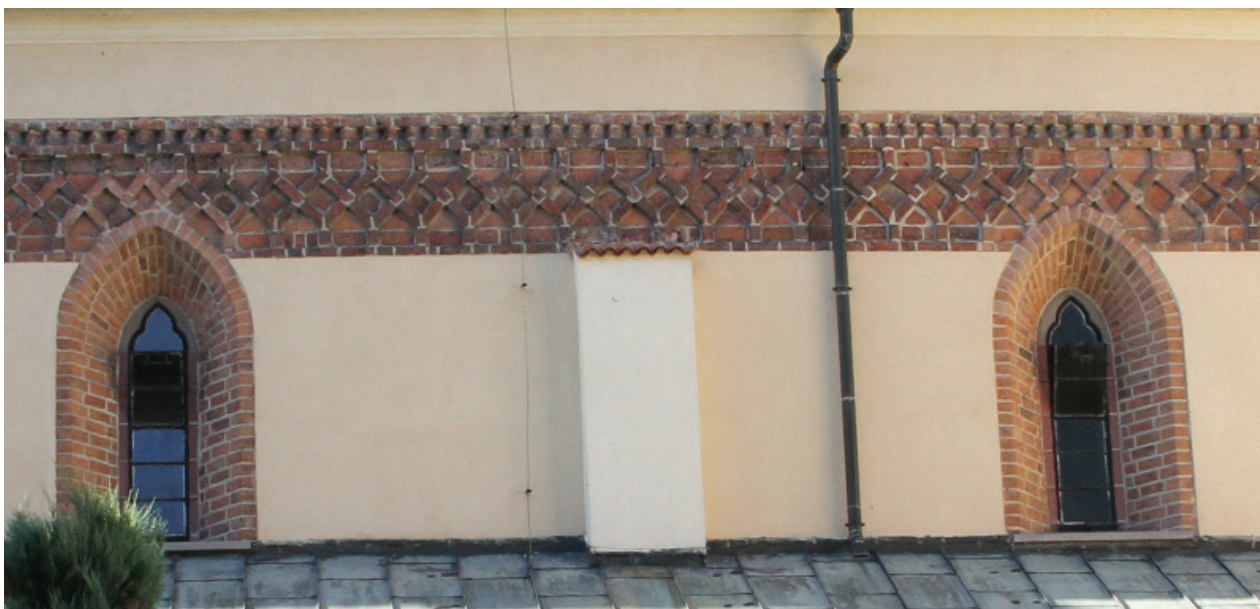
II. 2. Elewacja południowa kościoła, średniowieczny fryz i współczesne otwory okienne wprowadzone w czasie odbudowy realizowanej od 1945 r., stan obecny (fot. M. Dąbkowska)
