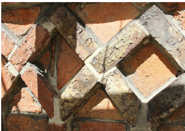
II. 3. Elewacja południowa prezbiterium kościoła, fryz dekoracyjny z nowożytnymi płytkami posadzkowymi, stan obecny (fot. M. Dąbkowska)
