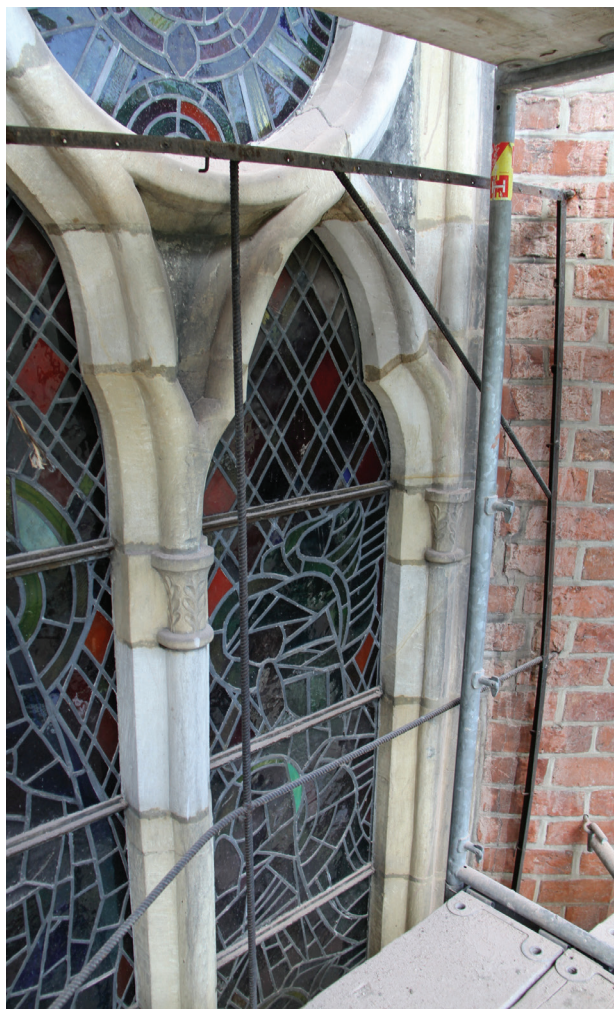
Il. 4. Okno w elewacji wschodniej kościoła wtórnie wykonane i zamontowane w czasie prac konserwatorskich przeprowadzonych po 1945 r., stan obecny (fot. M. Dąbkowska)
