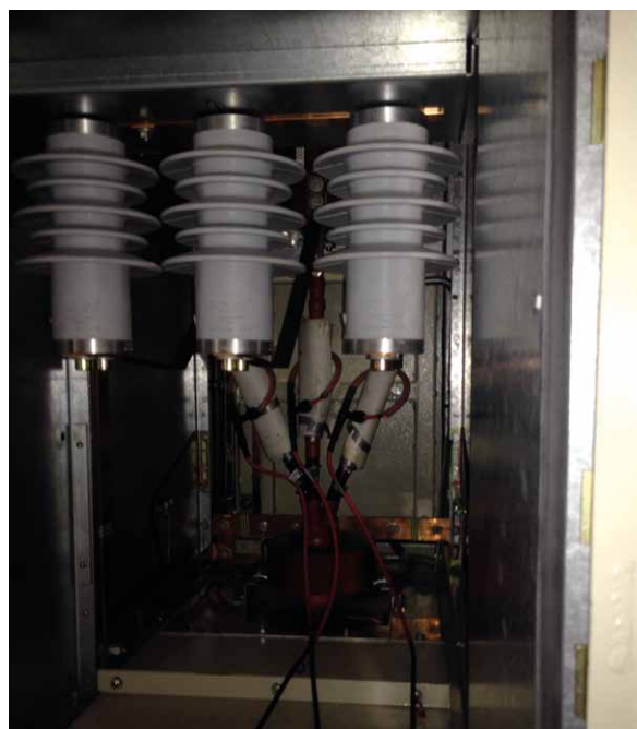
Rys. 19. Widok miejsca zamocowania cewek Rogowskiego na poszczególnych fazach zasilania badanego silnika
