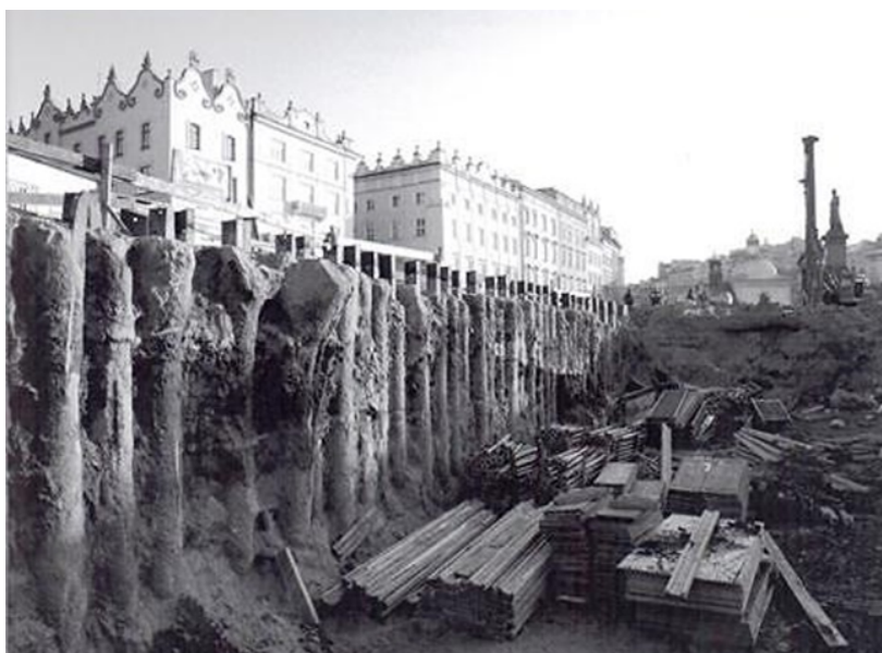
Rysunek 2. Palisadowe zabezpieczenie ścian podziemnego muzeum (pale żelbetowe o \phi 60 cm wciskane w grunt na głębokość 12 metrów) [1]
