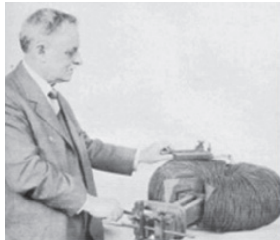
Rys. 4. Elihu Thomson ze swoim transformatorem toroidalnym do zgrzewania rezystancyjnego [6]
