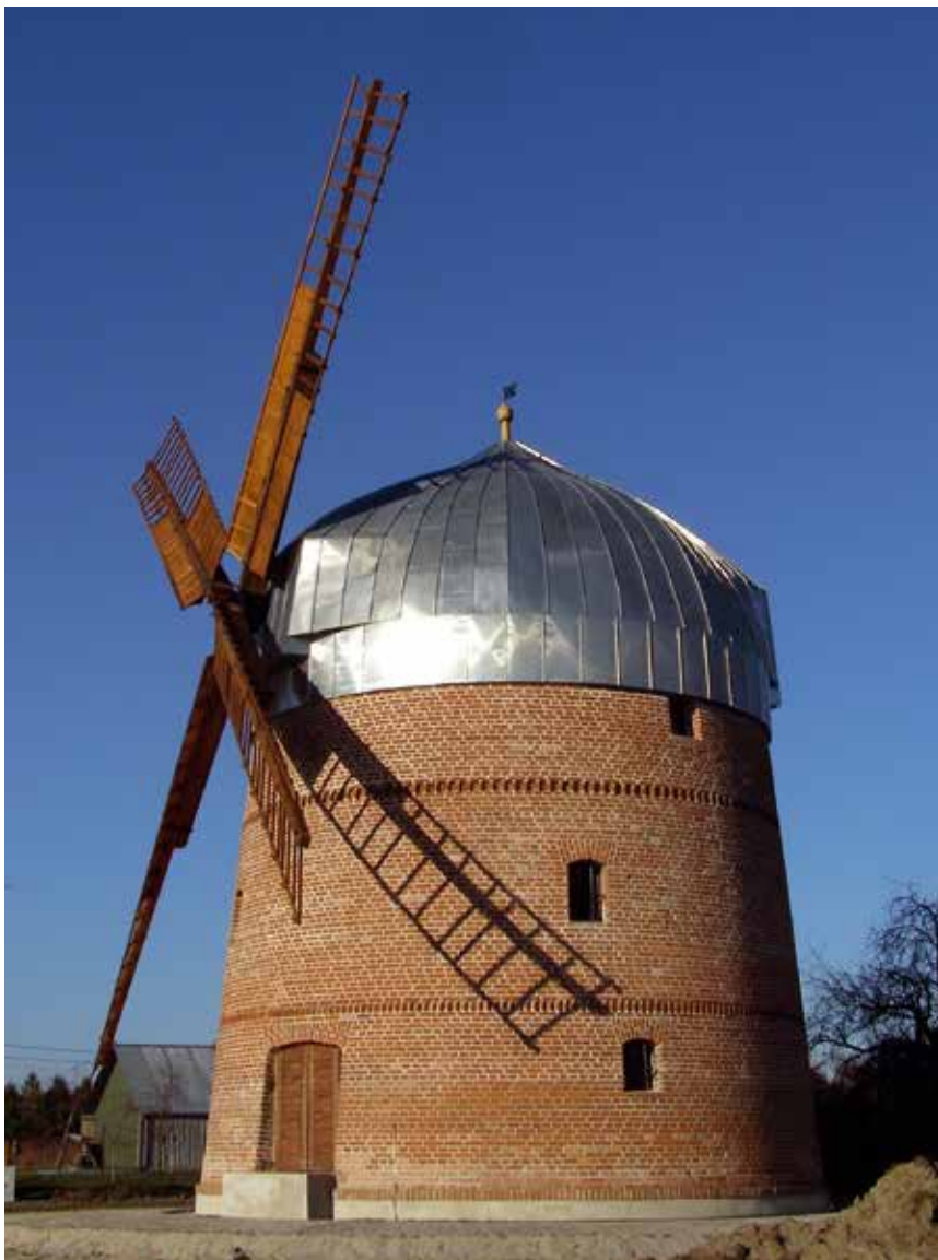
Il. 1. Murowany wiatrak „holenderski” w Pyzdrach (1903 r.); dach wiatraka pierwotnie obracany był za pomocą belek ogonowych, obecnie zainstalowano mechanizm wewnętrzny; źródło: fot. F. Tomaszewski, 16.01.2020 r.
