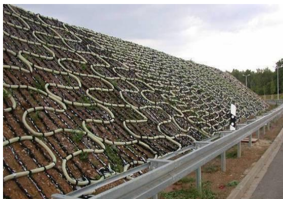
Rys. 1.2. Skarpa zbrojona innowacyjnymi geotekstyliami [7].
