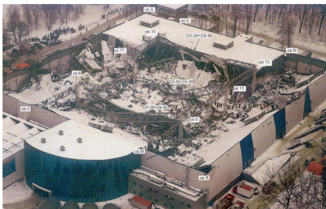
Rys. 4. Widok ogólny zawalonego dachu hali MTK, fot. archiwum GUNB [23]
