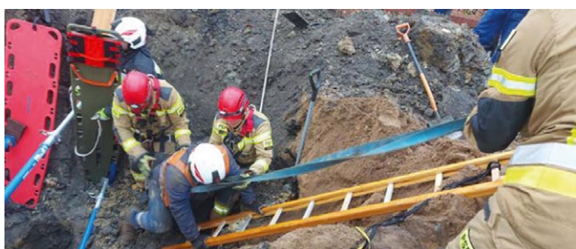
Rys. 3. Akcja ratownicza JRG, w wyniku której uratowano całkowicie przysypanego robotnika po oberwaniu się trzymetrowej skarpy, fot. z archiwum KP PSP [18]
