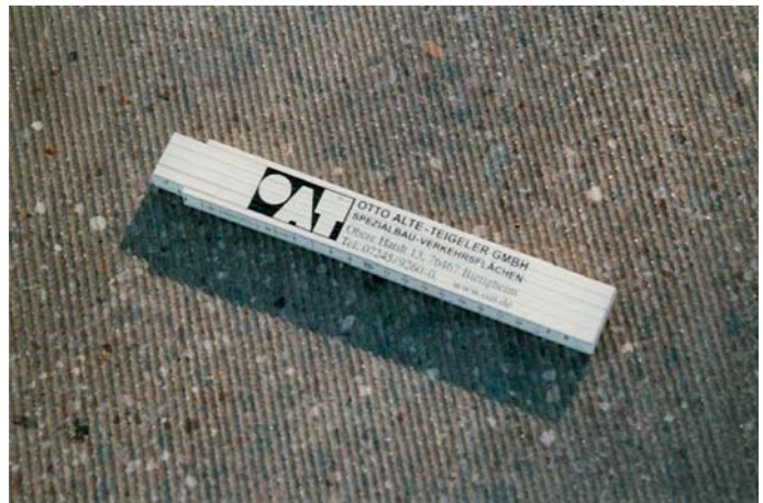
Fot. 14. Efekt teksturowania nawierzchni z betonu cementowego metodą grinding. Fot: Otto Alte-Teigeler GmbH
