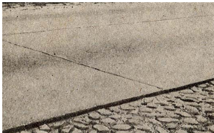
Fot. 3. Widok nawierzchni z betonu cementowego na drodze Warszawa – Białystok, odcinek Radzymin – Wyszków po 46 latach eksploatacji [4]
