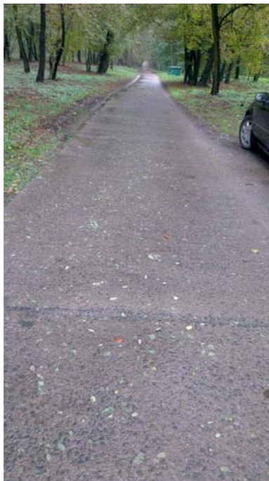
Fot. 4. (a–b). Widok 75-letniej nawierzchni z betonu cementowego na drodze dojazdowej do nieistniejącego obecnie lotniska wojskowego we wsi Sokołówek w powiecie Ciechanowskim. Obecnie jest to droga dojazdowa do magazynów oraz przyległych posesji. Zdjęcia wykonano w październiku 2015 roku
