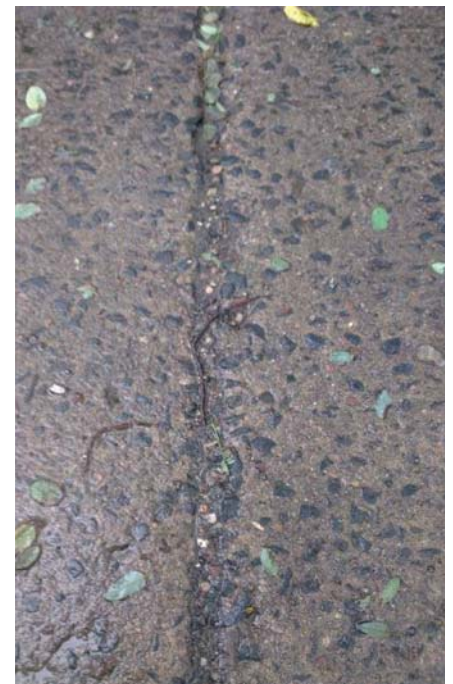
Fot. 5. (a–c) Zdjęcie po stronie lewej obrazuje widok tekstury nawierzchni po 75 latach eksploatacji. Dwa zdjęcia od prawej, pokazują proces degradacji krawędzi szczelin dylatacyjnych. Zdjęcia wykonano w październiku 2015 roku
