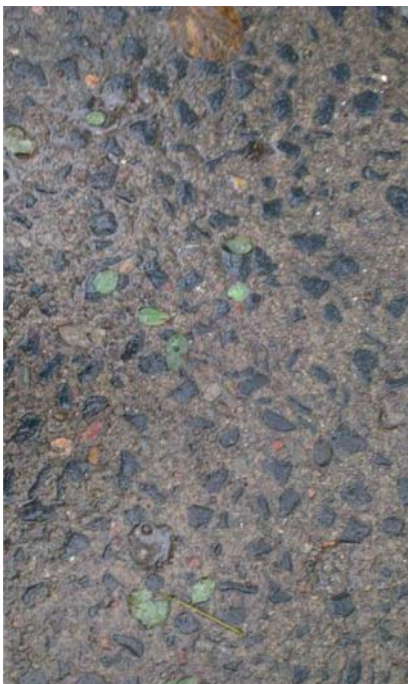
Fot. 5. (a–c) Zdjęcie po stronie lewej obrazuje widok tekstury nawierzchni po 75 latach eksploatacji. Dwa zdjęcia od prawej, pokazują proces degradacji krawędzi szczelin dylatacyjnych. Zdjęcia wykonano w październiku 2015 roku
