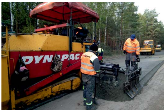
Fot. 11. (a–b). Wykonywanie nawierzchni z betonu wałowanego w ramach odnowy drogi wojewódzkiej nr 272 Laskowice – Jeżewo – Dolna Grupa. Nawierzchnia ta została wykonana w połowie października 2015 r. (Autor zdjęcia Piotr Różycki)
