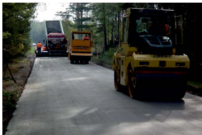
Fot. 11. (a–b). Wykonywanie nawierzchni z betonu wałowanego w ramach odnowy drogi wojewódzkiej nr 272 Laskowice – Jeżewo – Dolna Grupa. Nawierzchnia ta została wykonana w połowie października 2015 r. (Autor zdjęcia Piotr Różycki)
