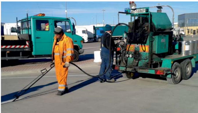
Fot. 12(a-f). Wizualizacja technologii wymiany masy uszczelniającej w szczelinach nawierzchni betonowej. Zdjęcia archiwum OAT Sp. z o.o.
