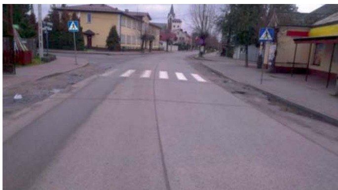
Fot. 8. Widok nawierzchni betonowej w miejscowości Wilga po 55 latach eksploatacji. Zdjęcie wykonano w listopadzie 2015 r.
