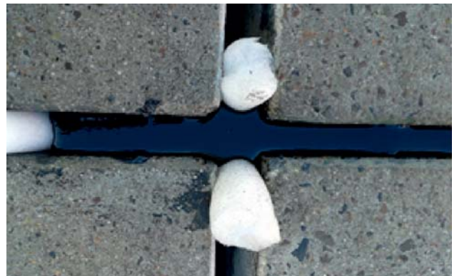
Fot. 12(a-f). Wizualizacja technologii wymiany masy uszczelniającej w szczelinach nawierzchni betonowej. Zdjęcia archiwum OAT Sp. z o.o.
