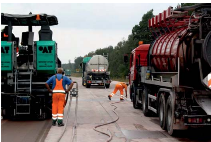
Fot. 13. Typowy zestaw maszyn do teksturowania nawierzchni z betonu cementowego metodą grinding. Fot: Otto Alte-Teigeler GmbH
