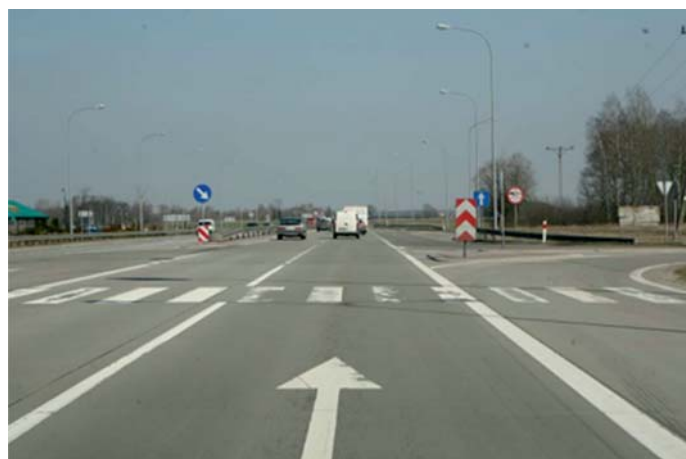
Fot. 10. Widok warstwy typu whitetopping na odcinku Wolbórz – Polichno po 12 latach eksploatacji
