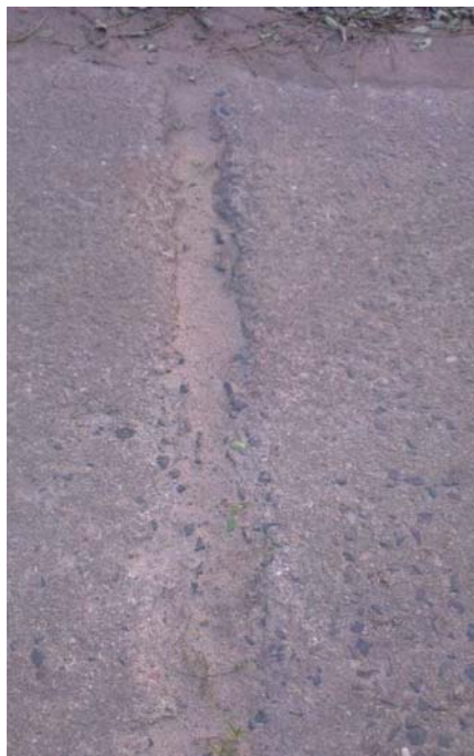
Fot. 5. (a–c) Zdjęcie po stronie lewej obrazuje widok tekstury nawierzchni po 75 latach eksploatacji. Dwa zdjęcia od prawej, pokazują proces degradacji krawędzi szczelin dylatacyjnych. Zdjęcia wykonano w październiku 2015 roku
