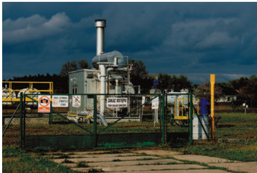
Rys.9. Strefa przyodwiertowa odwiertu Barnówko - 2 Fig. 9. Barnówko -2 borehole zone
