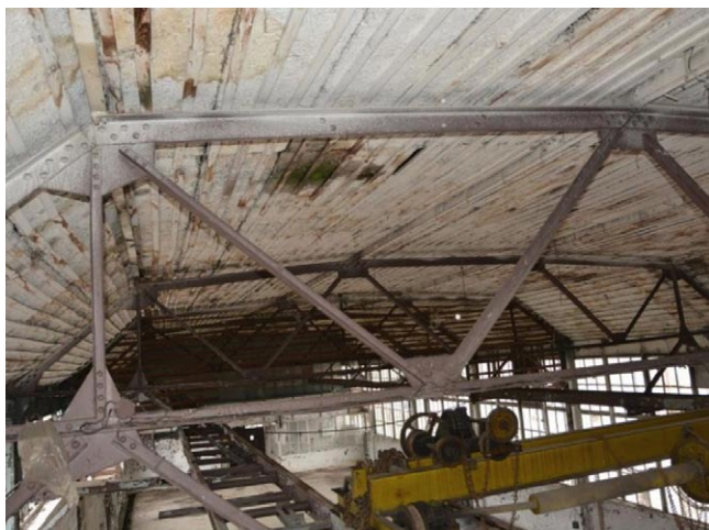
Rys. 2. Zbliżenie kratownicy dachowej hali, widoczny tor jezdny suwnicy i suwnica
