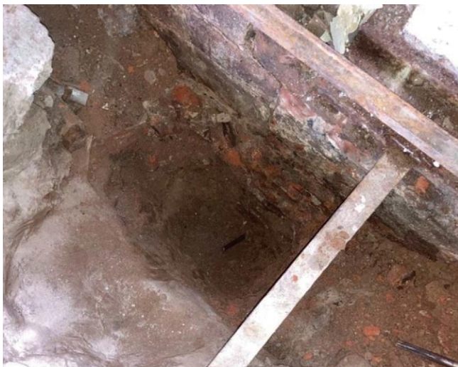
Rys. 4. Odkrywka wewnątrz hali, widoczny zachowany płaskownik łączący podstawę słupa z posadzką
