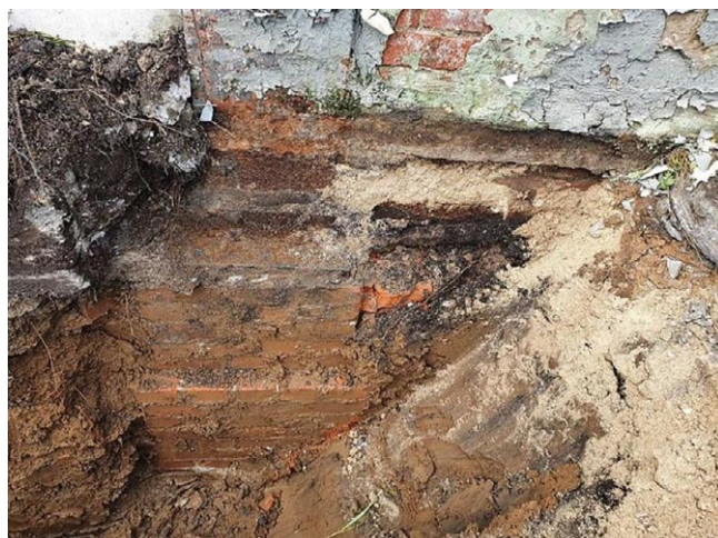
Rys. 3. Odkrywka stopy ceglanej pod słupem stalowym
