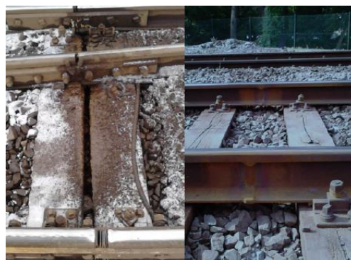
Rys. 1 Szyny połączone na złączki szynowe (po lewej) oraz zespane (po prawej) [5]
