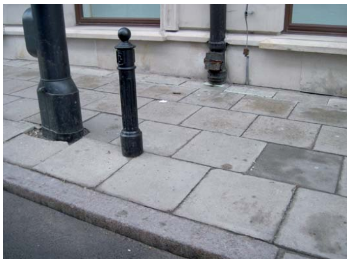
Fot. 1. Przykład odprowadzenia wody z dachu bezpośrednio do kanalizacji – Warszawa
