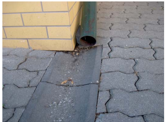
Fot. 2. Przykład odprowadzenia wody z dachu za pośrednictwem chodnika – Warszawa
