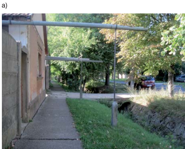
Fot. 3a i 3b. Przykłady sposobów odprowadzenia wody z dachu do rowów odwadniających z pominięciem chodnika – Hajdúböszörmény (Węgry)
