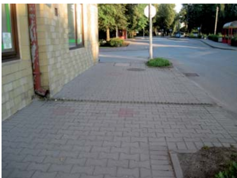
Fot. 12. Korytko z prefabrykatów o skarpach pochylonych – Ustrów
