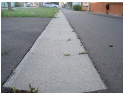
Fot. 17. Przykład korytka ściekowego zaobserwowanego na węgierskich chodnikach (zagłębienie: 1,5 cm) wg [16] – Hajdúböszörmény (Węgry)
