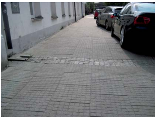
Fot. 13. Korytko o skarpach wyokrąglonych kostką kamienną łupaną (obszar zabytkowy) – Płock
