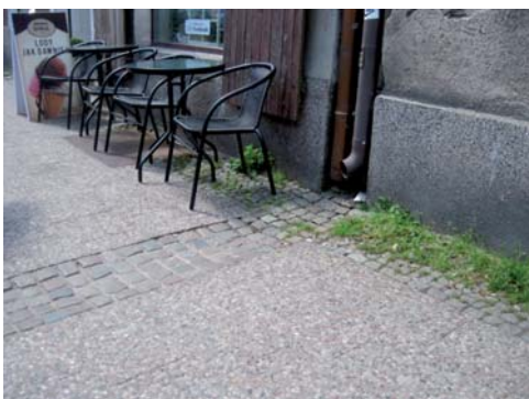
Fot. 14. Korytko o skarpach wyokrąglonych kostką z kamienia polnego (obszar zabytkowy) – Gdańsk
