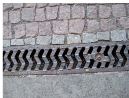
Fot. 7. Zastosowanie odwodnienia liniowego specjalnie zaprojektowanego dla bezpiecznego poruszania się osób niepełnosprawnych (ruszt żeliwny, szczeliny 2 cm zorientowane pod kątem) – Frydek-Mistek (Czechy)
