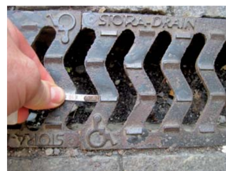
Fot. 7. Zastosowanie odwodnienia liniowego specjalnie zaprojektowanego dla bezpiecznego poruszania się osób niepełnosprawnych (ruszt żeliwny, szczeliny 2 cm zorientowane pod kątem) – Frydek-Mistek (Czechy)
