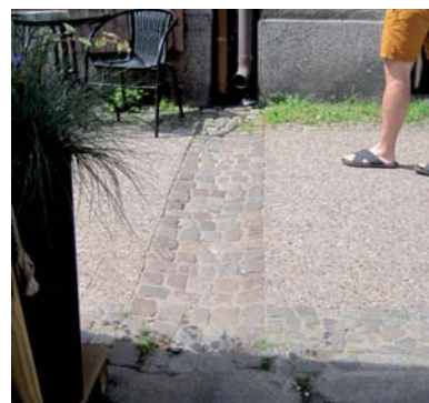
Fot. 14. Korytko o skarpach wyokrąglonych kostką z kamienia polnego (obszar zabytkowy) – Gdańsk
