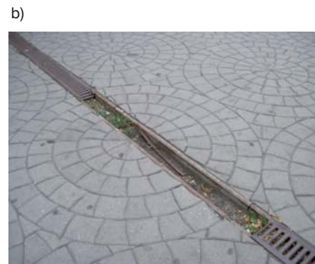
Fot. 6a i 6b. Typowe uszkodzenia odwodnienia liniowego z cienkiego stalowego rusztu – Ostrawa (Czechy)
