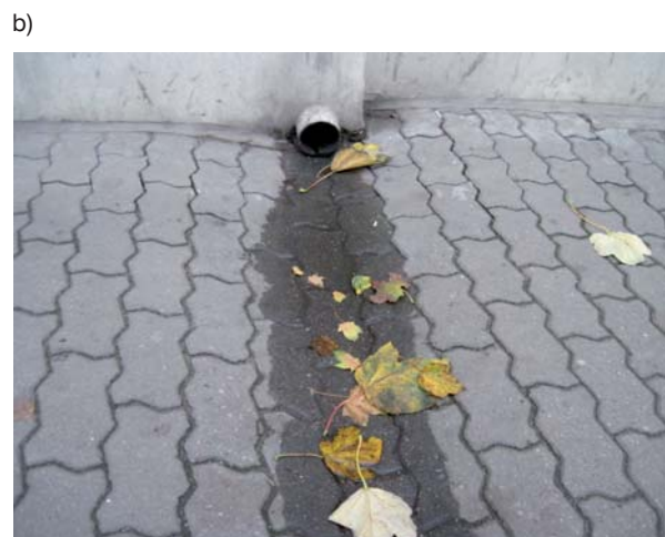
Fot. 5a i 5b. Sens stosowania korytek – niewielki spływ wody odbywa się tylko w obrębie korytka – Siedlce, Gorzów Wlkp.
