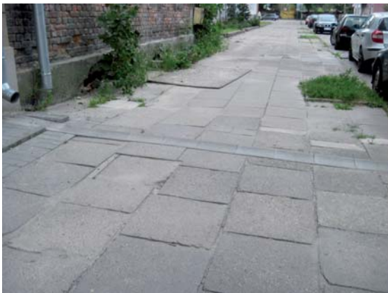
Fot. 11. Korytko z prefabrykatów wyokrąglonych – Gdańsk
