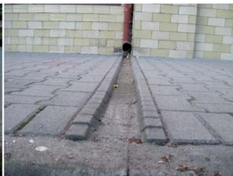
Fot. 12. Korytko z prefabrykatów o skarpach pochylonych – Ustrów
