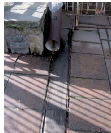
Fot. 8. Zastąpienie przy odwodnieniu liniowym rusztu z otworami deską drewnianą pełną – Zakopane
