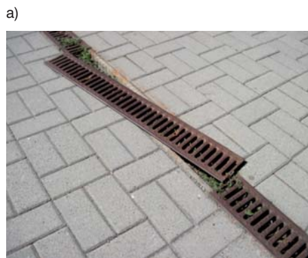
Fot. 6a i 6b. Typowe uszkodzenia odwodnienia liniowego z cienkiego stalowego rusztu – Ostrawa (Czechy)
