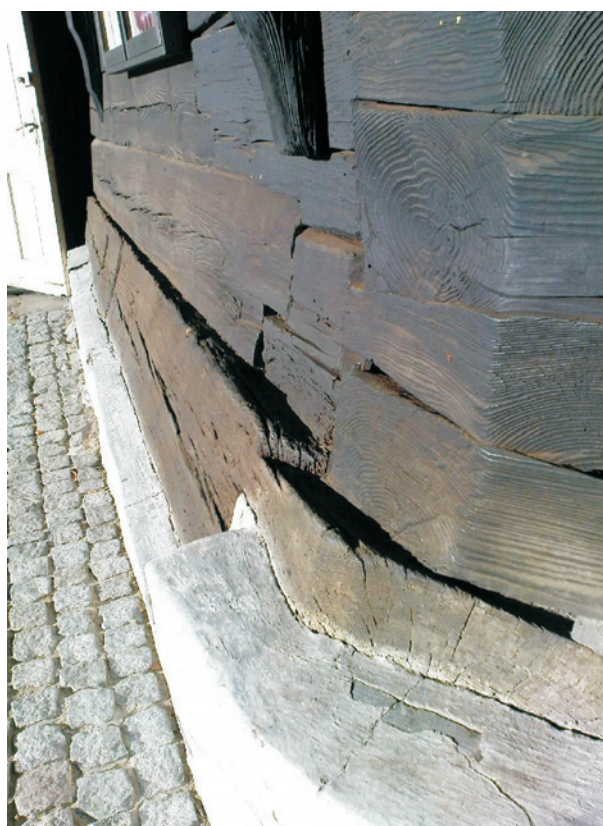
Ryc. 6. Podwalina południowej ściany prezbiterium kościoła w Poniszowicach; fot. autor, 2009
