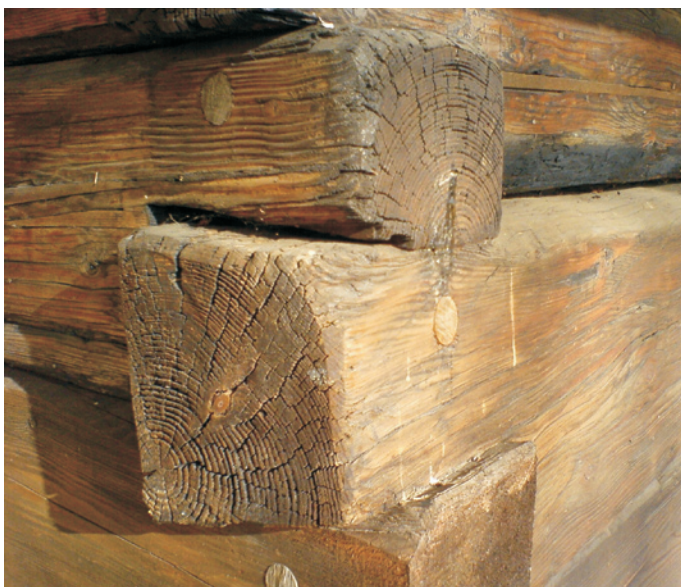
Ryc. 5. „Ostatki”, czyli zakończenia bierwion w konstrukcji wieńcowej, występowały w kościołach drewnianych prawdopodobnie już w XV w. Tu na przykładzie Kościoła w Żernicy z 1648 r.; fot. autor, 2007
