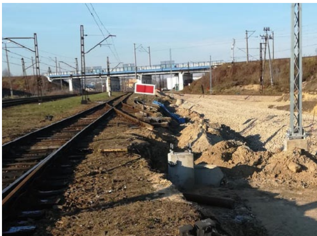
Rys. 2. Przykładowe zabezpieczenie toru zamkniętego tarczą D-1 (źródło: materiały własne)
