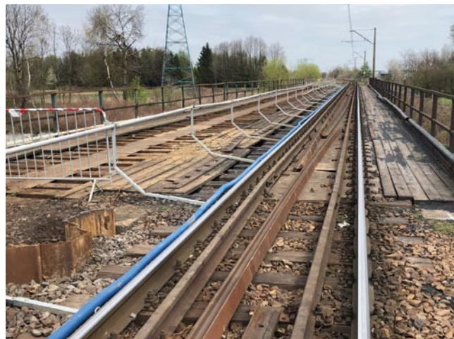
Rys. 3. Wygradzenie międzytorza barierami (źródło: materiały własne)
