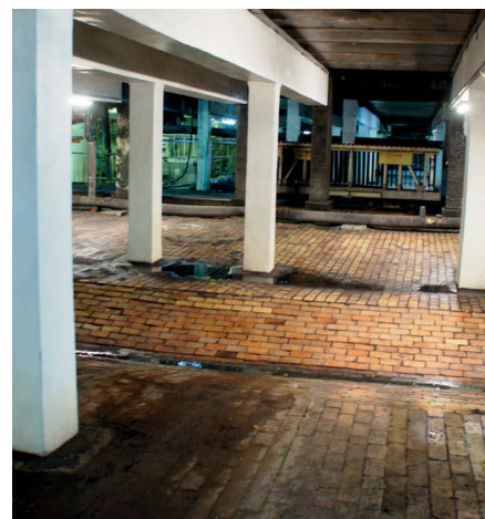
Rys. 1. Posadzka z płytek kwasoodpornych
