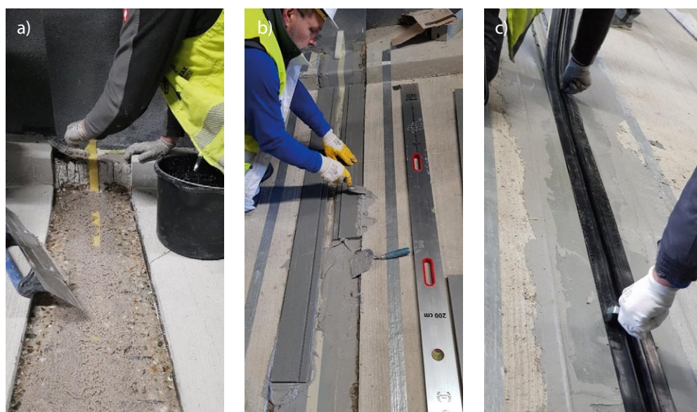
Rys. 11. Etapy naprawy dylatacji konstrukcyjnej: a) reprofilacja ubytków, b) ułożenie kleju montażowego, wklejenie membrany i paneli dylatacyjnych, c) wklejenie nakładki gumowej [26]
