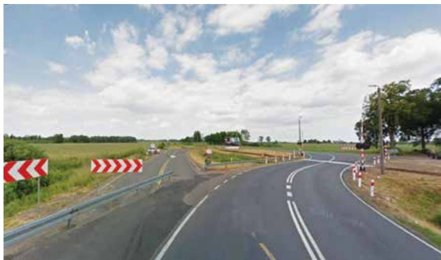
Widok przejazdu kategorii B na drodze krajowej i wyjazdu z drogi wewnętrznej
