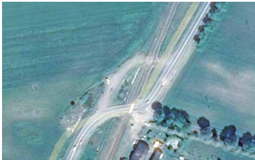
Widok przejazdu kategorii B na drodze krajowej oraz miejsca po zlikwidowanym przejeździe kategorii F i fragmencie drogi wewnętrznej
