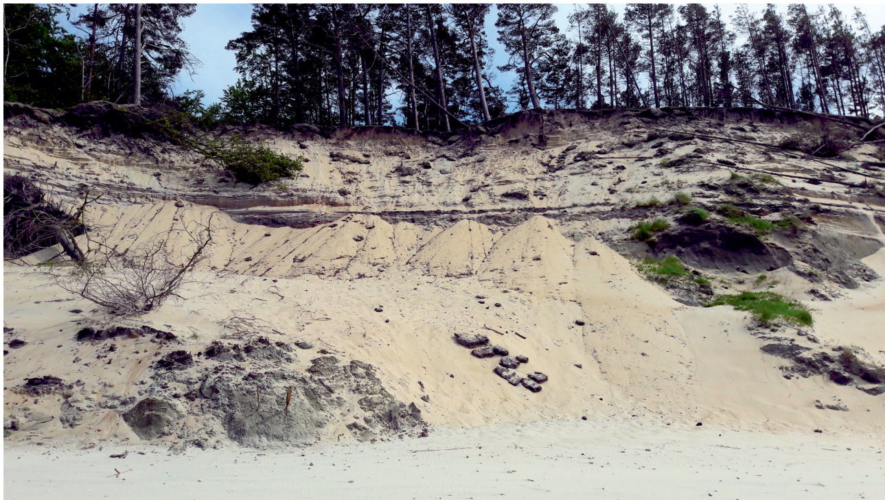
Ryc. 4. Stożki osypiskowe w rejonie 229,70 km UM (fot. J. Frydel, 2016)
