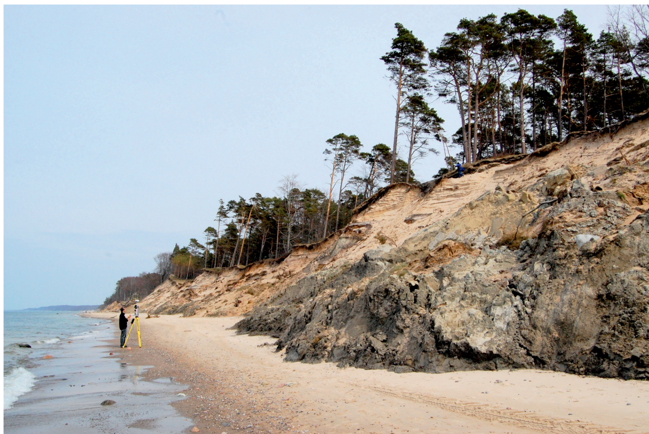
Ryc. 7. Osuwisko przy 229,65 km UM (fot. W. Jegliński, 2010)
