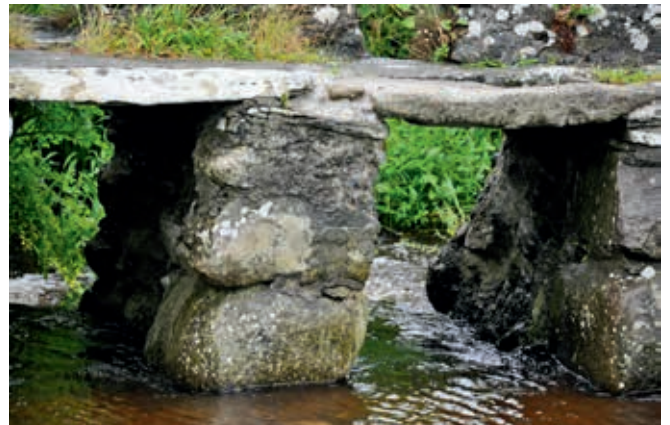
Ryc. 22. Szczegół kładki Clapper w Bunlahinch
