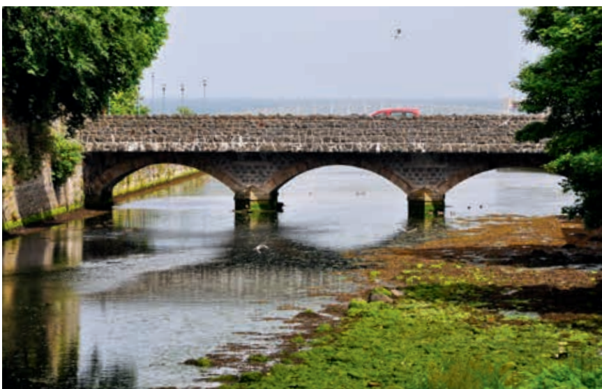
Ryc. 3. Betonowy, trójprzęsłowy most z okładziną kamienną w Glenarm
