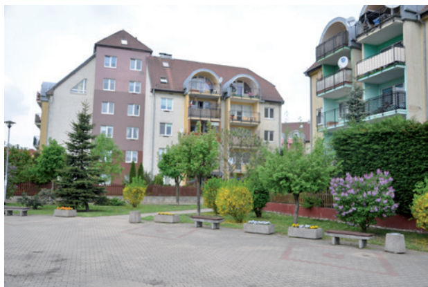
il. 5. Osiedle Zielone Pole na Przeclawiu (koło Szczecina). Na pierwszym planie półkolisty plac (centralna przestrzeń publiczna), na drugim planie budynki wraz z przedogórkami / View of the housing estate Zielone Pole in Przeclaw
