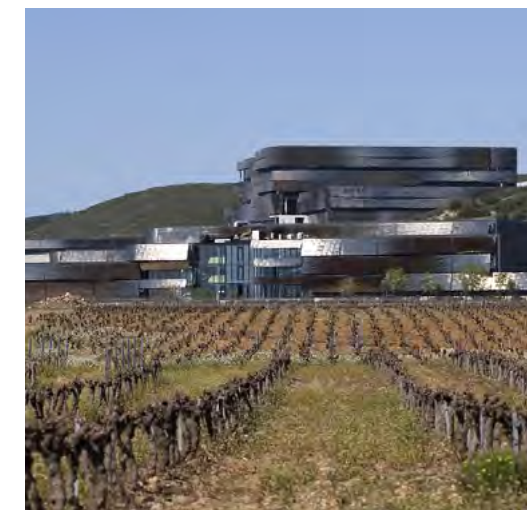
Rys. 4. Spalarnia odpadów komunalnych Calce [10]
