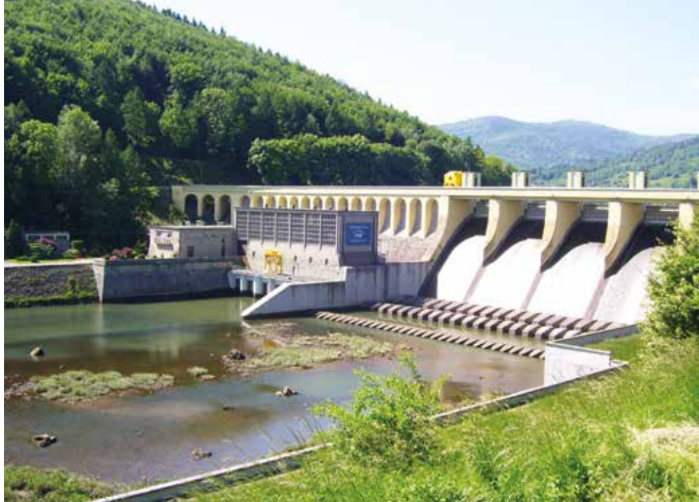
Rys. 13. Żelbetowa zapora wodna w Porąbce – Międzybrodziu
