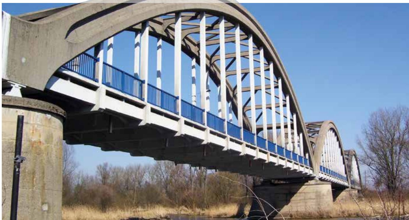
Rys. 14. Żelbetowy most nad Pilicą koło Białobrzegów
