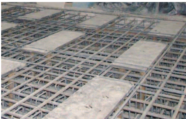
Rys. 6. Widok zbrojenia płyty
