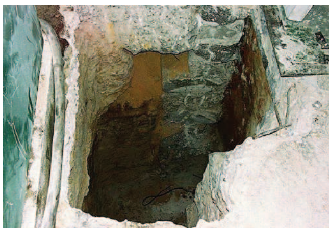
Rys. 3. Odkrywka płyty wielkich sił od strony planowanego styku
