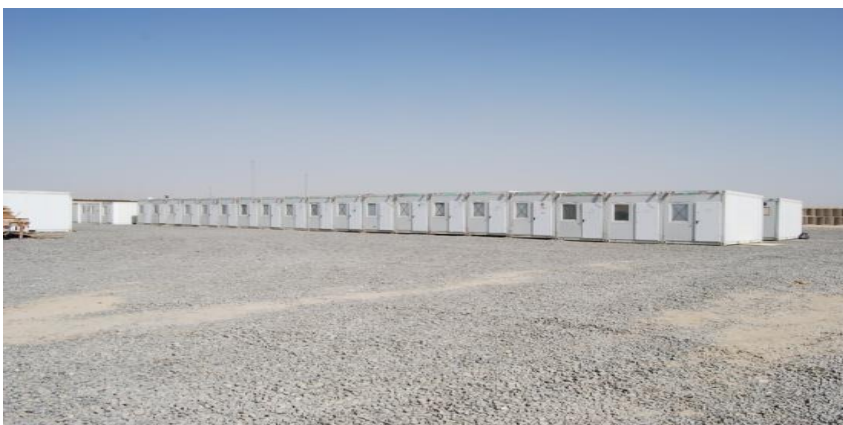
Rys. 3. Kontenery mieszkalne w FOB GHAZNI w Afganistanie
