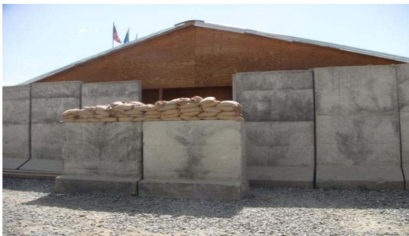
Rys. 1. Stanowisko dowodzenia zabezpieczone żelbetonowymi barierami
