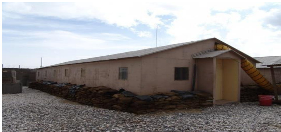
Rys. 4. Budynek mieszkalny w FOB GHAZNI w Afganistanie
