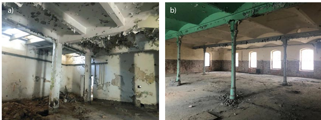
Rys. 2. Widok stropów w pomieszczeniach skrzydła lewego: a) południowego na parterze, b) południowego na piętrze
