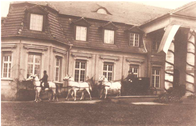
Ryc. 20. Pałac w Bieganowie, elewacja frontowa, 1926. Źródło: archiwum rodzinne potomków Edwarda Grabskiego
