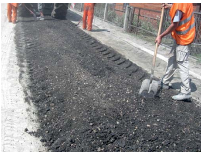
Fot. 6. Mieszanka MCAS po przejściu recyklera a) Wirtgen WR 2000 (droga powiatowa Nr 0382T, Tokarnia, 2010 r.), b) Wirtgen WR 4200 (DW 744, Radom-Wierzbica-Starachowice, 2013 r.)
