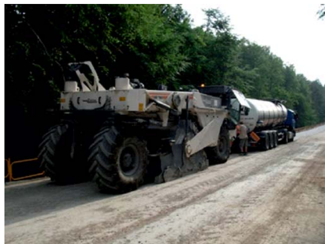
Fot. 5. Zestaw maszyn do recyklingu głębokiego na zimno z asfaltem spienionym (DW nr 753, Huta Nowa-Wólka Milanowska, 2011 r.)
