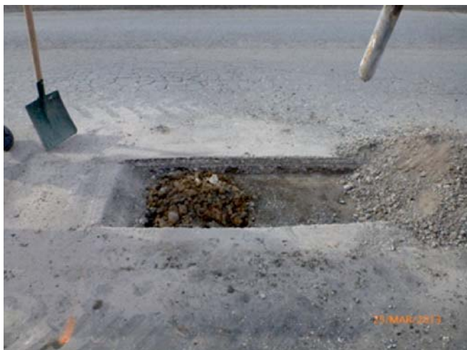
Fot. 2. Rozpoznanie układu i rodzaju istniejących warstw konstrukcji nawierzchni i podłoża (DW nr 744, Radom-Wierzbica-Starachowice, 2013 r.)
