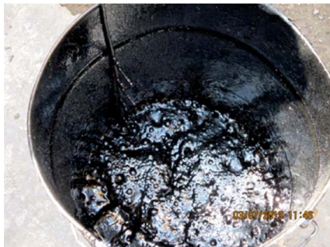
Fot. 3. Kontrola w warunkach polowych parametrów piany asfaltowej pobranej z dyszy recyklera
