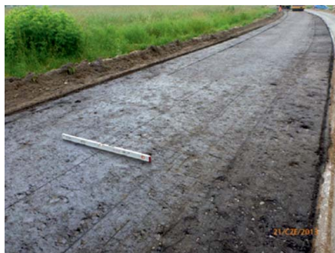
Fot. 6. Mieszanka MCAS po przejściu recyklera a) Wirtgen WR 2000 (droga powiatowa Nr 0382T, Tokarnia, 2010 r.), b) Wirtgen WR 4200 (DW 744, Radom-Wierzbica-Starachowice, 2013 r.)
