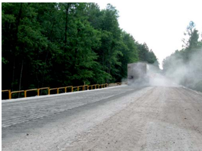
Fot. 4. Rozsypywanie środka wiążącego przed przejazdem recyklera (DW nr 753, Huta Nowa-Wólka Milanowska, 2011 r.)
